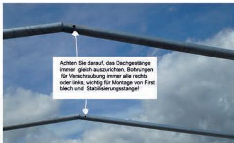
Achten Sie darauf, das Dachgestänge immer gleich auszurichten, Bohrungen für Verschraubung immer alle rechts oder links, wichtig für Montage von Firstblech und Stabilisierungsstange!
