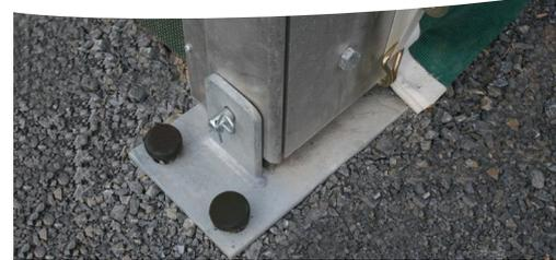
Fixation dans le sol à l'aide de piquets de sol - fondations pas nécessaires
