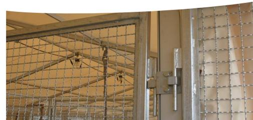
Les treillis de séparation sont fixés directement sur la charpente à l'aide d'un adaptateur.
